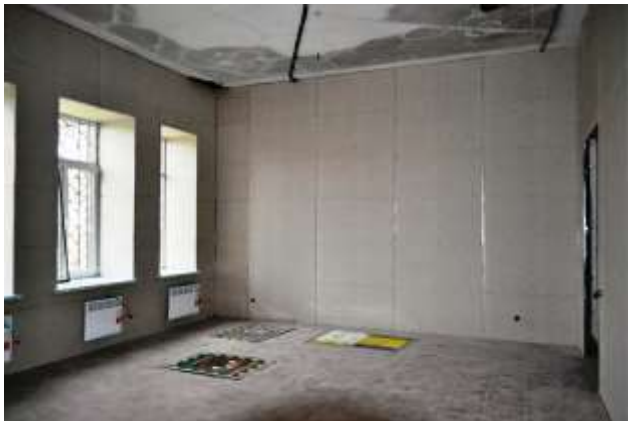
Фото. Ремонт приміщення
