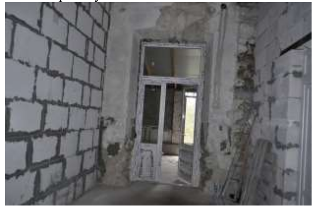
Фото. Ремонт приміщення
