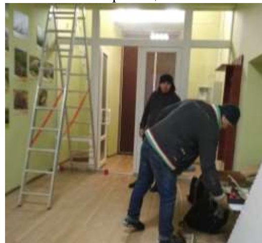
Фото. Монтаж системи охоронної сигналізації
